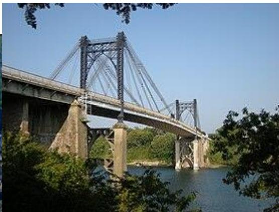
Le pont de Lézardrieux est un pont suspendu sur le Trieux construit entre 1836 et 1840, profondément modifié en pont à haubans de type Gisclard en 1925. Pour permettre le passage de la ligne des Chemins de Fer des Côtes-du-Nord entre Paimpol et Tréguier.
